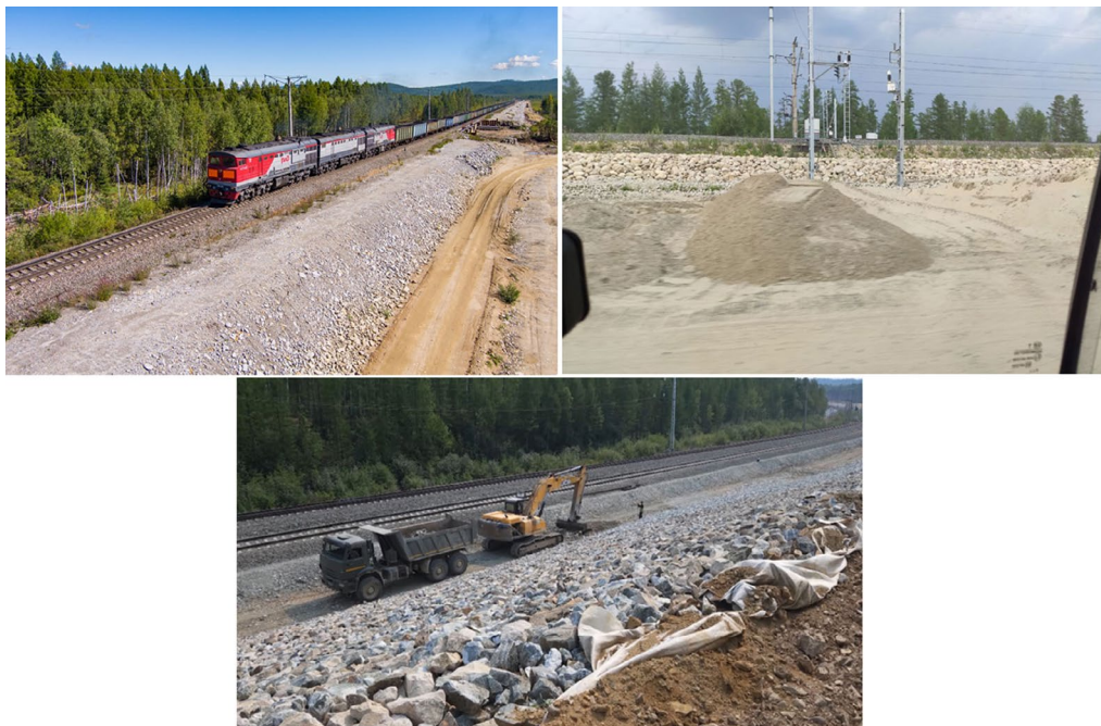
Рис.1. Строительство второй ветки БАМ в бассейне р. В. Ангара, июль 2024 г.
